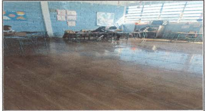
Foto 2: Piso ceramico terminado al cien por ciento
