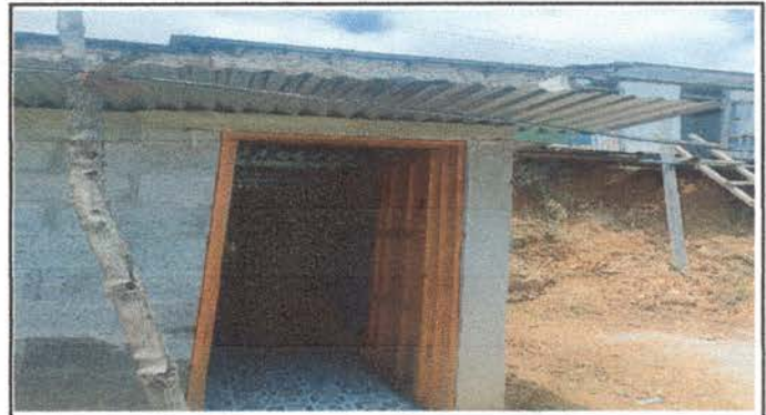
Foto 4: Sanitarios terminados al cien por ciento
