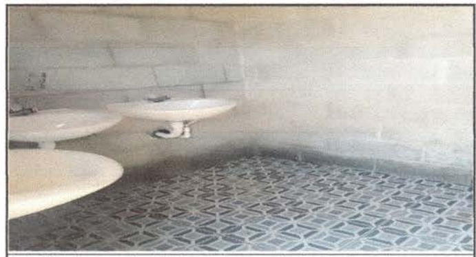
Foto 6: Lavamanos instalados al cien por ciento
