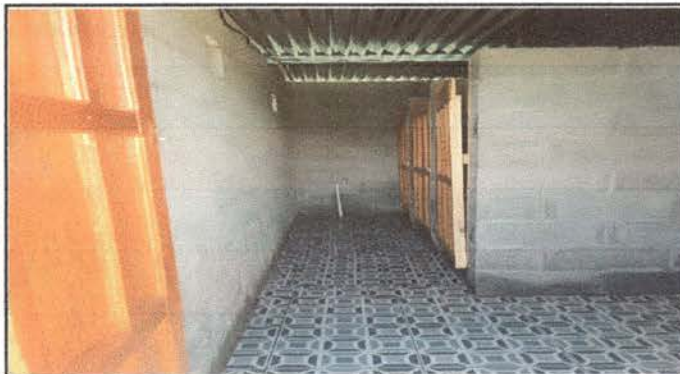
Foto 3: Sanitarios terminado al cien por ciento
